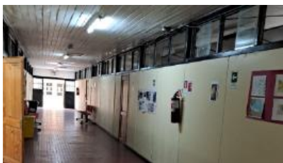
Extintores Pabellon Sur
